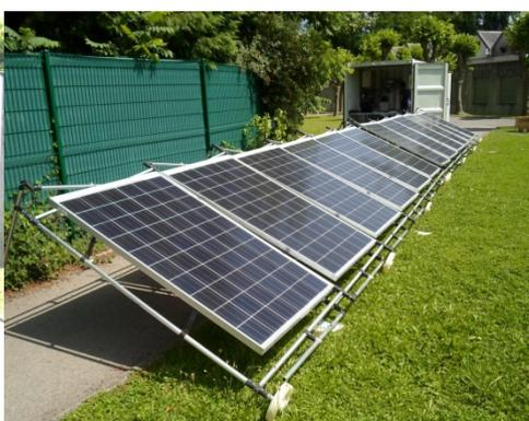
En partenariat avec l'entreprise Schneider Electric, nous disposons d'un container qui permet de déployer une installation photovoltaïque en site isolé permettant d'alimenter rapidement une installation suite à une situation d'urgence (événement climatique ayant entraîné une perte de l'alimentation électrique).
