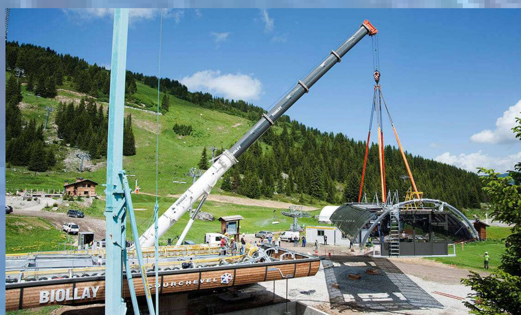
➤ Montage de la couverture d'une gare
