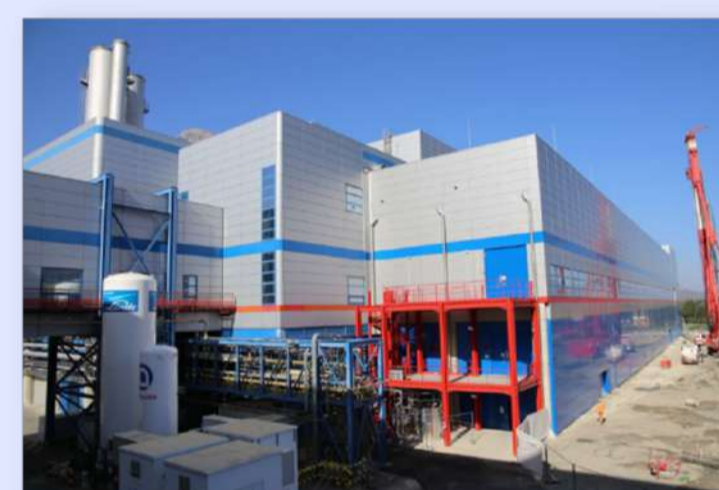
Nouveaux bâtiments ST Gateway 1 - 2
